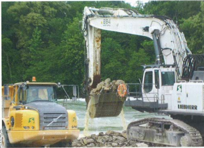
Bei Maschineneinsatz in umweltsensiblen Gebieten ist es zwingend, dass Maschinen nur mit Betriebsmitteln mit geringst möglicher Umweltgefährdung im Einsatz sind. Alle auf dem Bild zu sehenden Maschinen sind mit PANOLIN HLP SYNTH unterwegs.
