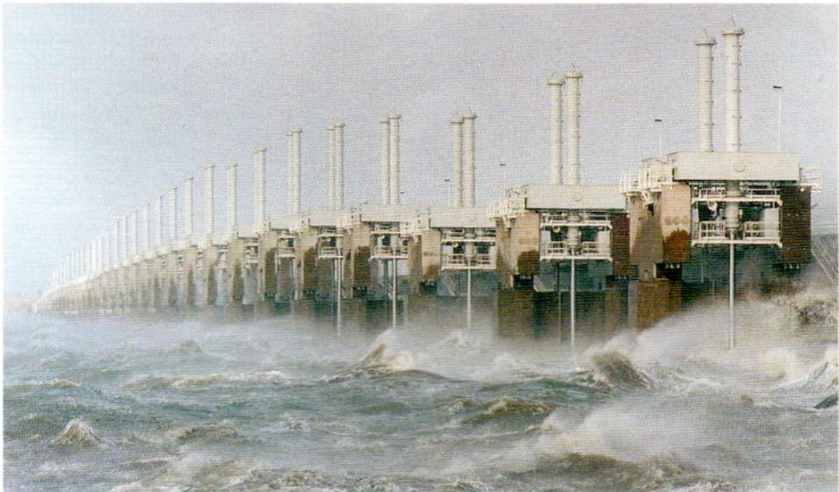
Abb. 1: Um den Naturgewalten zu trotzen, müssen Stahlwasserbauten immer funktionieren!
