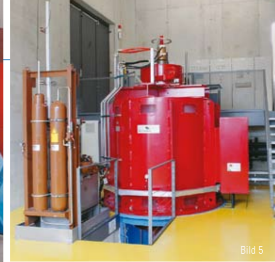
Bild 1: TIWAG, Inn-KW Langkampfen/Tirol Bild 2: TIWAG, Inn-KW Langkampfen/Tirol Bild 3: TIWAG, Inn-KW Langkampfen/Tirol Bild 4: ÖBB, KW Braz/Vorarlberg Bild 5: ILLWERKE-VKW, KW Rieden-Bregenz/Vorarlberg
