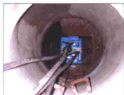
Grabenlose Rohrrenewerung von Schacht zu Schacht
