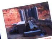
Leistungsstarke Mischtechnik für riesigen Staudamm
