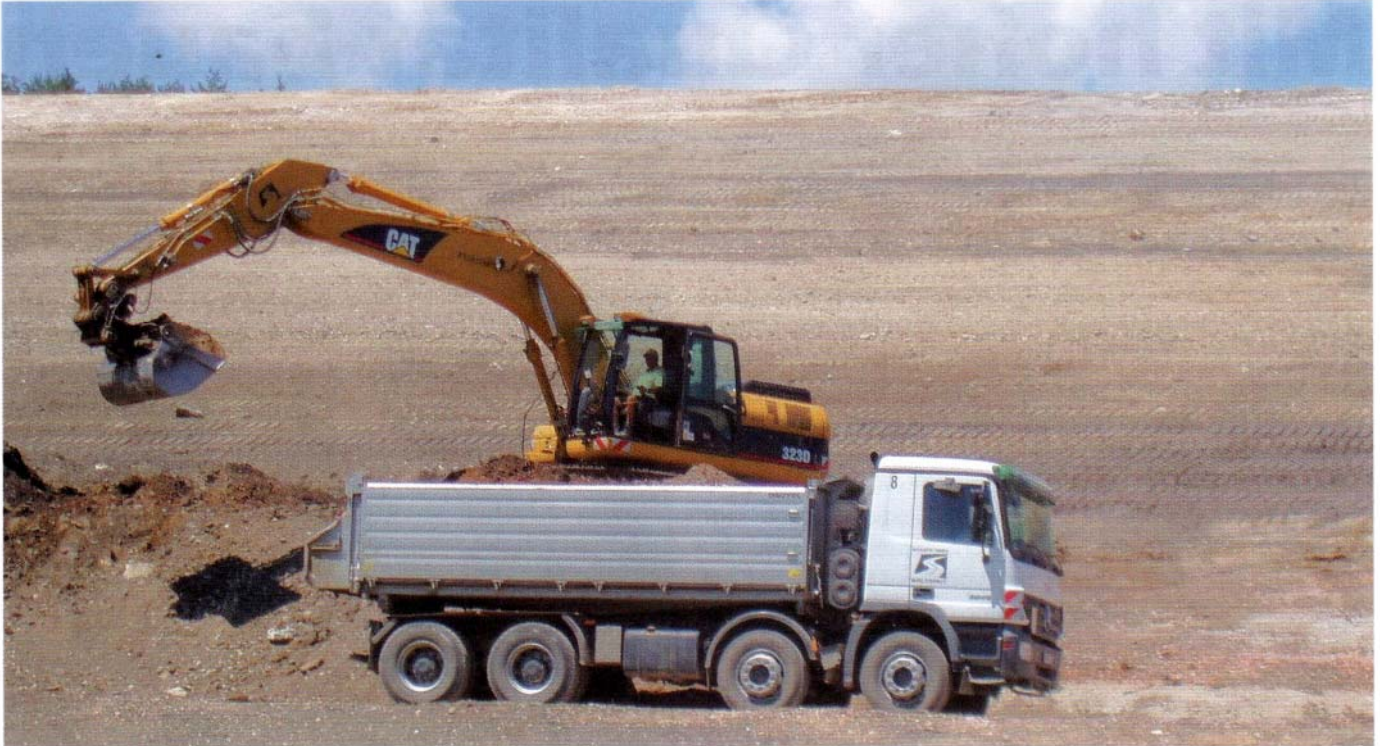
Auch Deponiebau gehört zum Schleith Leistungsspektrum
