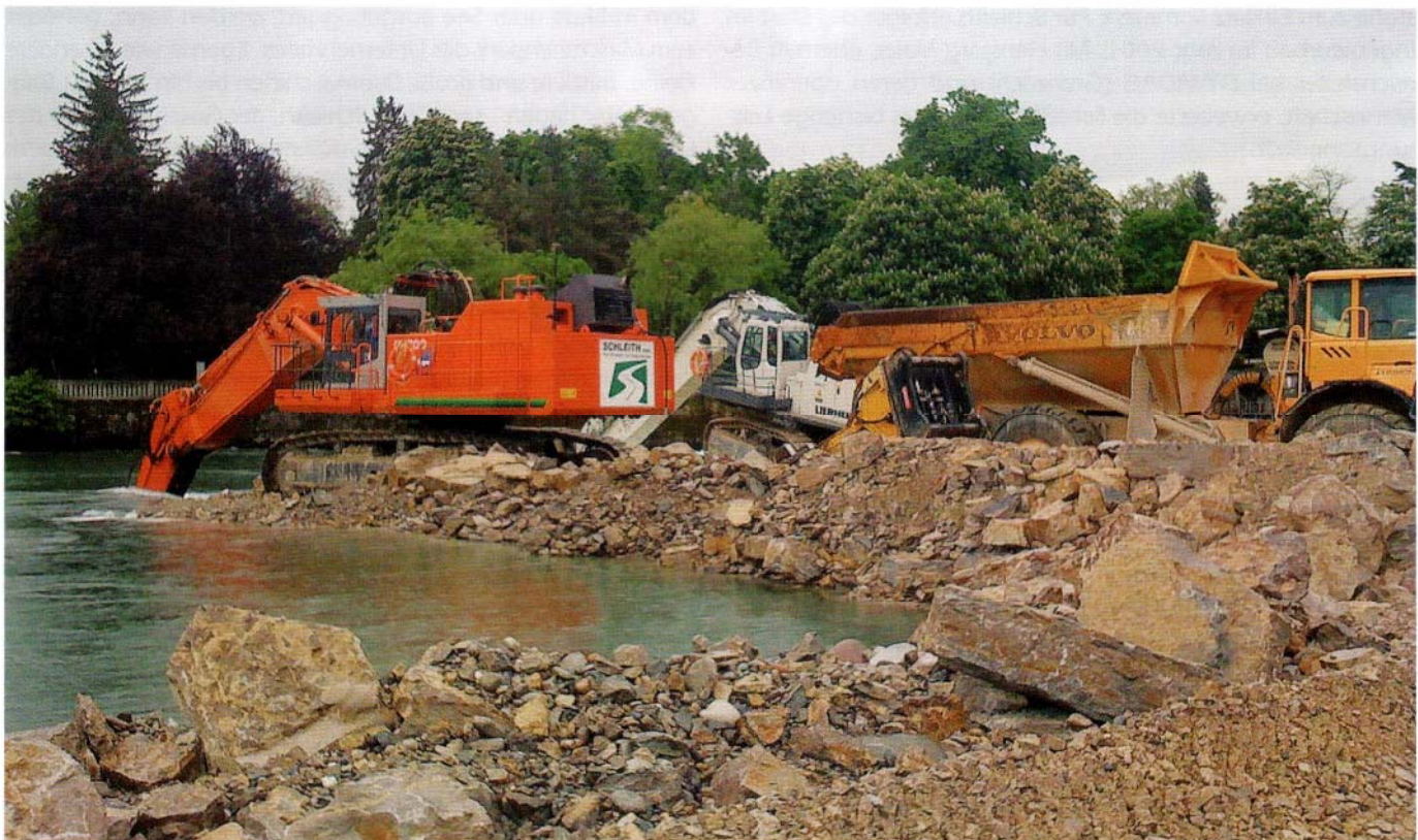
Ein umfangreicher Maschinenpark mit 120 t und 130 t Baggern gehört Schleith
