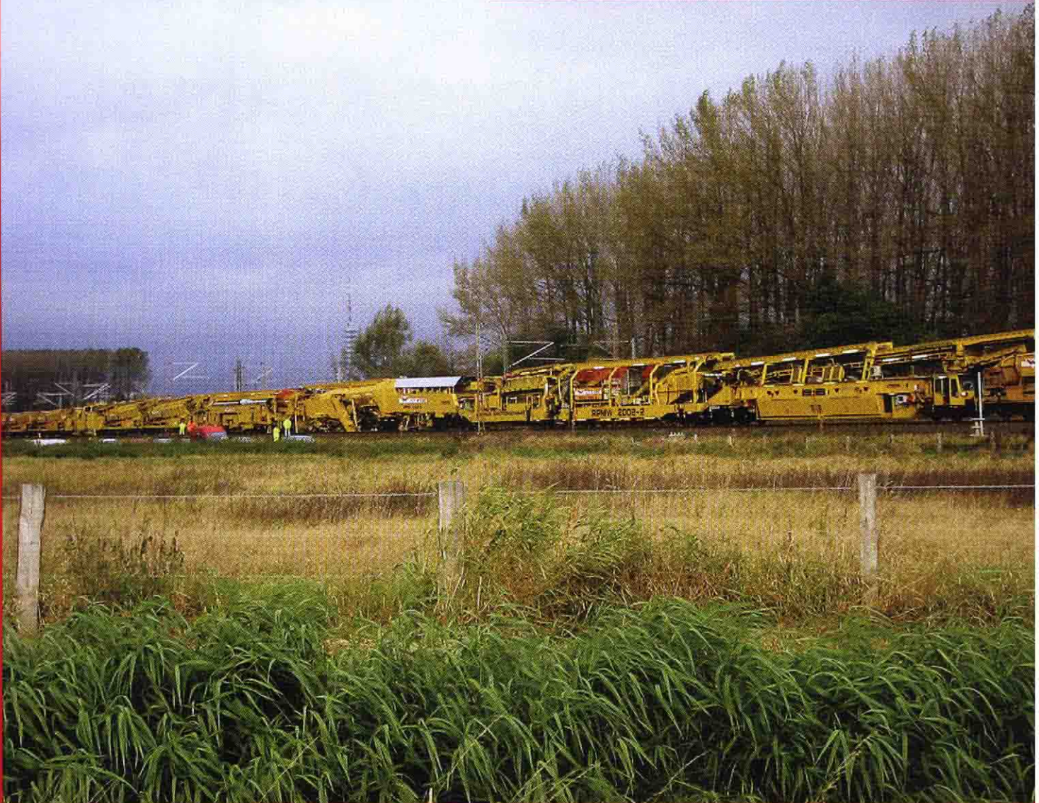
600 m lang kann eine Wiebe Gleisbaumaschine sein
